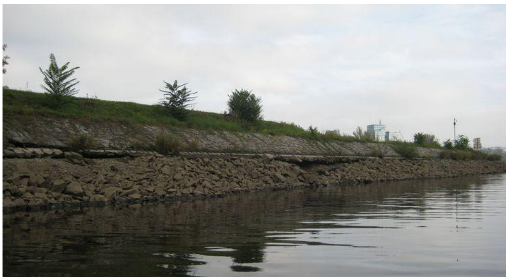
Foto č.6 – stav opevnění v době povypuštěné zdrže
